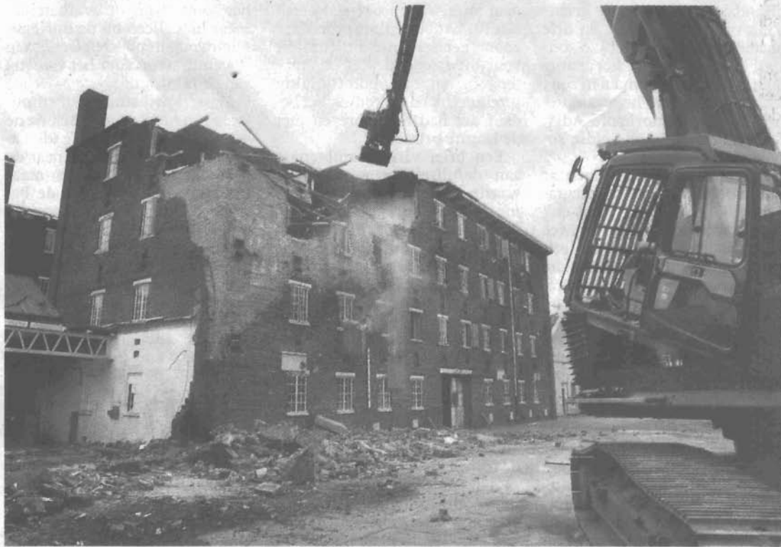
De nu gesloopte bollenschuren waren de hoogste van de streek.
